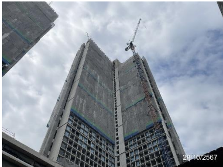
ภาพที่ 2.2-4 ตาข่ายกันฝุ่น (Mesh Sheet)
