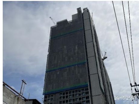
ภาพที่ 2.2-4 ตาข่ายกันฝุ่น (Mesh Sheet)
