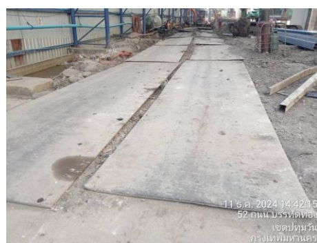
ภาพที่ 2.2-46 การปูพื้นด้วยแผ่นเหล็กบริเวณ ที่ไม่มีการปฏิบัติงาน
